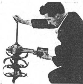
Auf den rechten inneren Hackstern folgt dann das Getriebegehäuse. Das Getriebegehäuse wird so über die Hackwelle gezogen, daß der Ölstopfen und die Öse für die Befestigung der Stellstrebe später bei der Arbeit nach oben zeigen.
